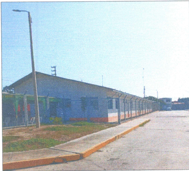
Construcción de ambientes complementarios (IQARR) para la atención y Hospitalización de pacientes COVID, Exteriores del Hospital de Apoyo Casma
